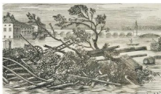
Rupture du chemin de fer à Tarascon - Idem
