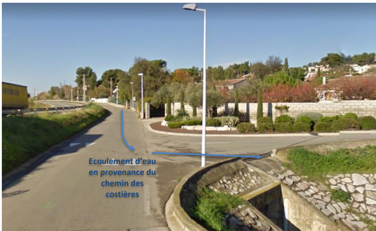
Illustration 23 : Aménagements surfaciques organisant l’écoulement surfacique dû à l’insuffisance du réseau pluvial
