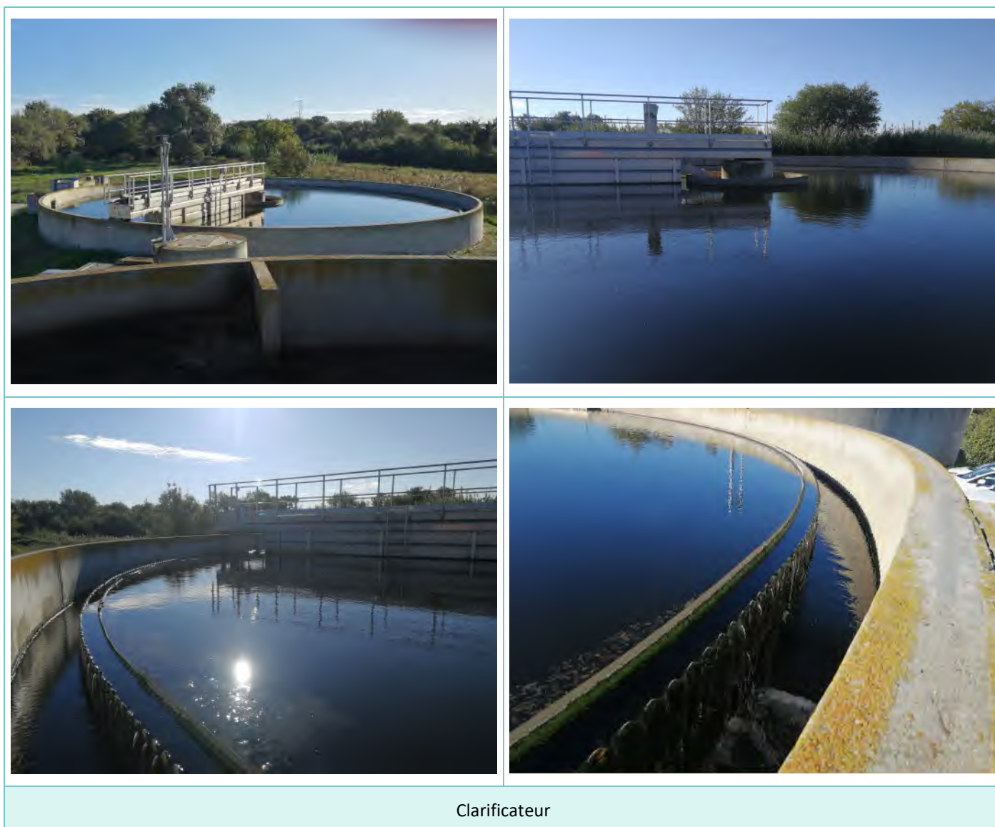
Figure 9 : Planche photographique du clarificateur
