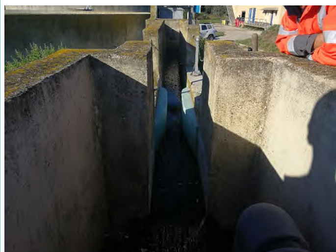
Canal de sortie Venturi - mesure des eaux traitées et rejetées au contre canal (point réglementaire A4)
