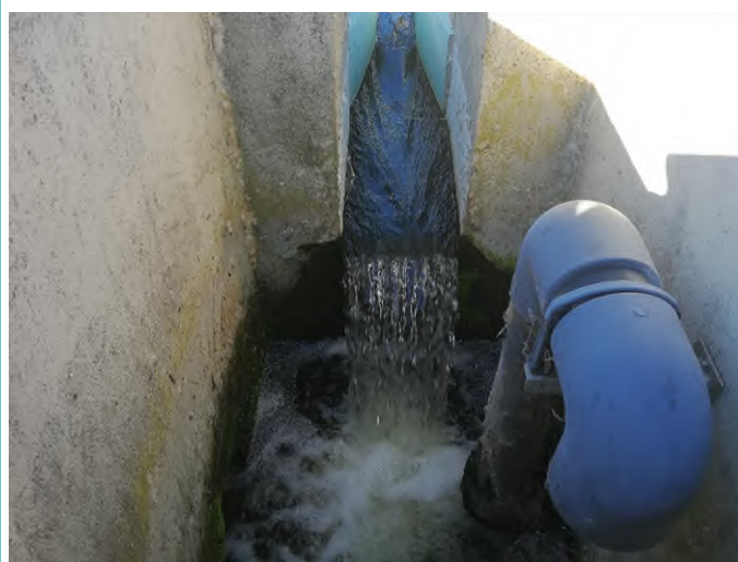
Canal de sortie Venturi - mesure des eaux traitées et rejetées au contre canal (point réglementaire A4)
