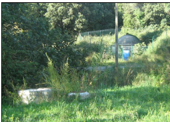
Figure 11 – Edifice de la source Ouest de la Route de REDESSAN (avec sa clôture grillagée) et collecteur des eaux des deux sources au premier plan
