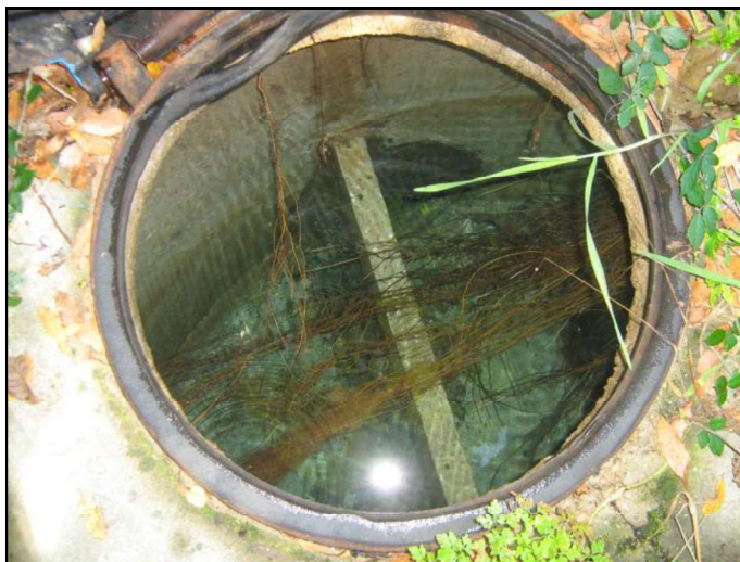
Figure 12 – Vue de l’intérieur d’un des capots Foug montrant le départ de la galerie de captage
