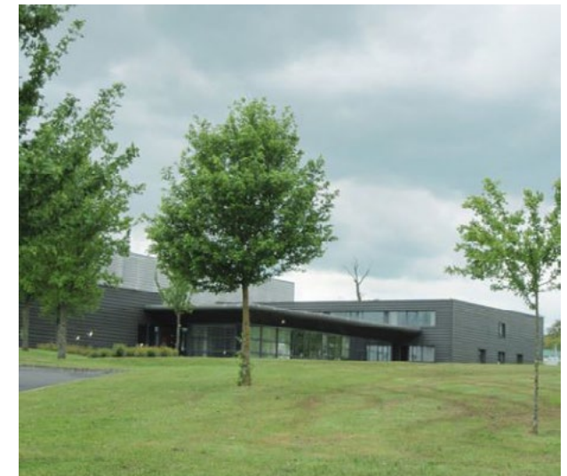
Façades en matériaux discrets - Parc d'activités de Tronquières à Aurillac (15).
