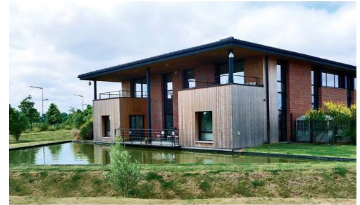
Centre technique municipal de Sucé-sur-Erdre (44).
