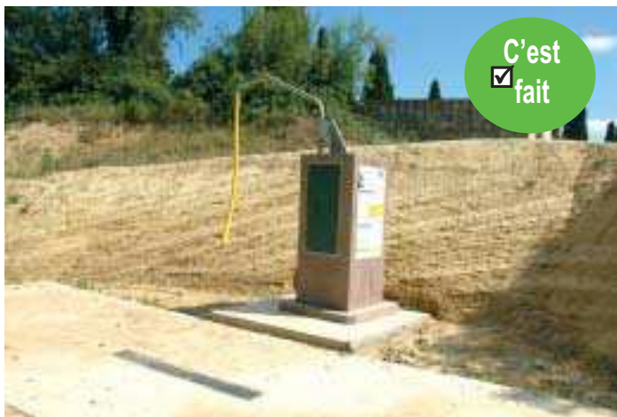
Aide à l'agriculture: Installation de bornes de remplissage (2 installées).
