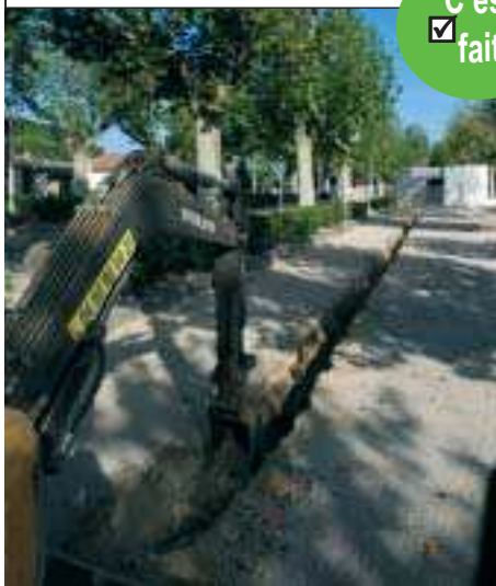
Installation d'un réseau d'irrigation des platanes de la place B. Bonnet.
